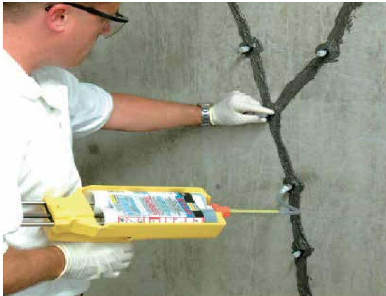
本工法主要解决各种结构裂缝的处理问题。包括需要补强的裂缝、需要止水堵漏的裂缝、以及动载情况下的裂缝。裂缝宽度从0.1 ~ 6.35mm。
